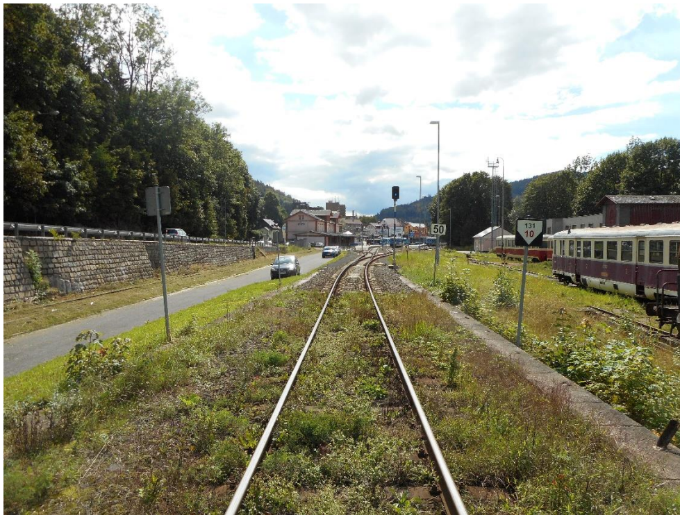
OBRÁZEK 1 - ZNEČIŠTĚNÉ ŠTĚRKOVÉ LOŽE V KM 27,600
