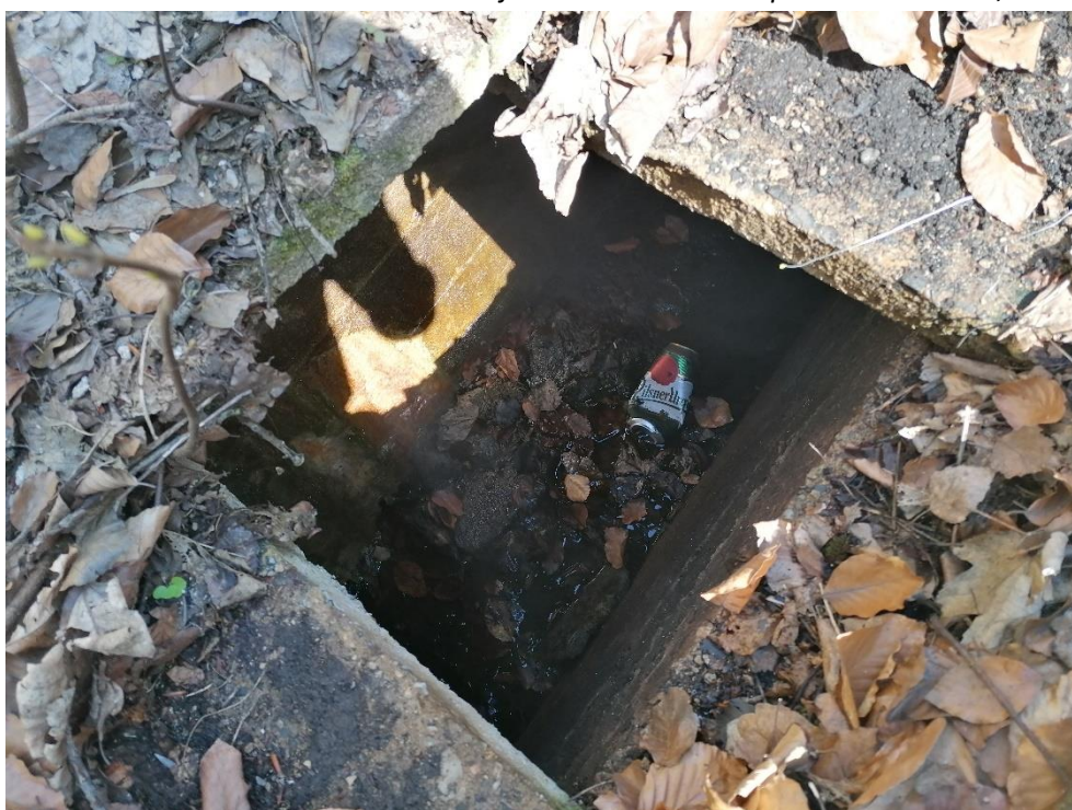
Obrázek 4 - Znečištěné odvodnění v km 27,860
