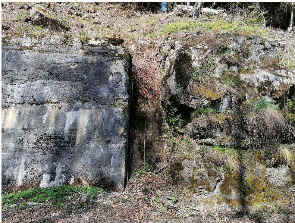
Obrázek 7 - Zanešená horská vpust' a skluz v km 27,870
