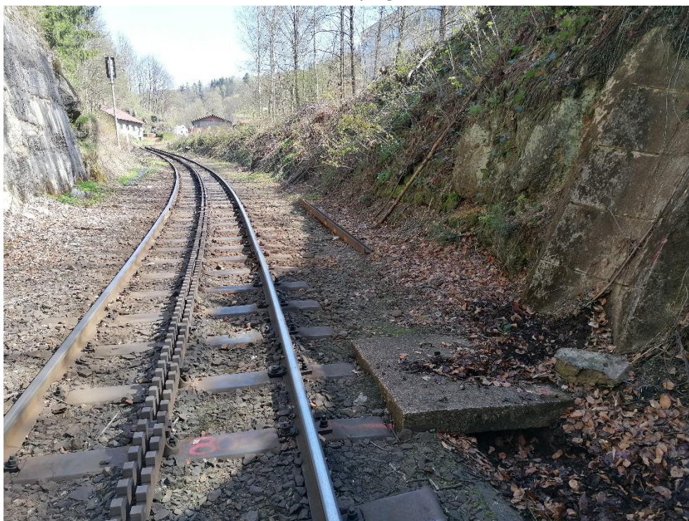
Obrázek 6 - Zanešená horská vpusť v km 27,870
