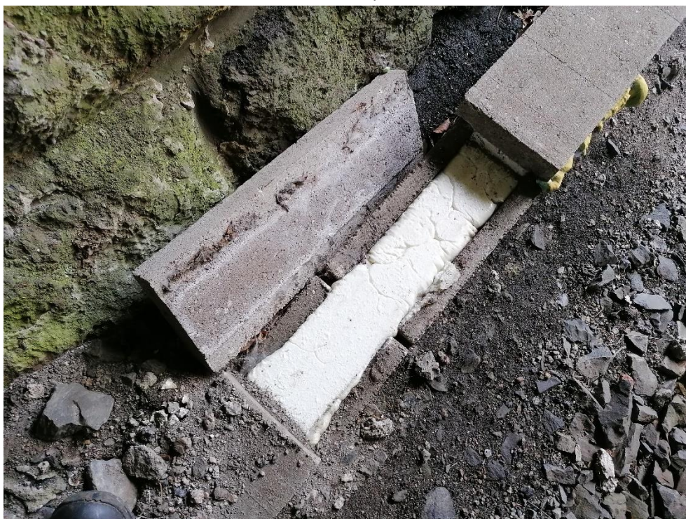
Obrázek 8 - Zafoukaná kabelová trasa ve Žďárském tunelu
