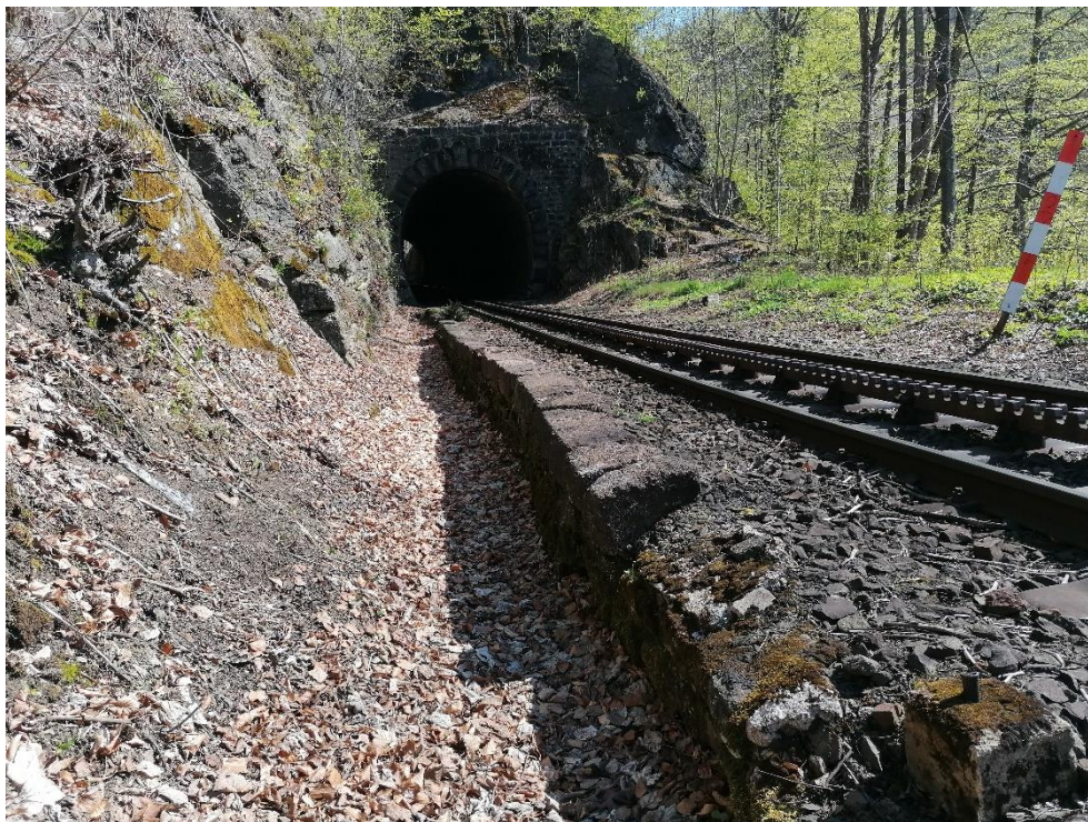
Obrázek 5 - Poškozený rigol v km 27,740
