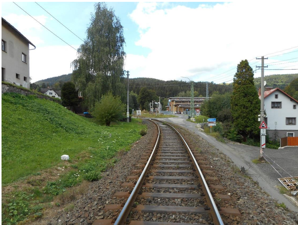
Obrázek 3 - Nedostatečná šířka kolejového lože v místě opěrné zdi v km 28,400
